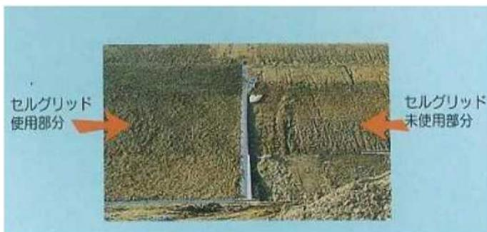
セルグリッドに土壌等を充填しますと、セル内で充填材が拘束されて、風や水で動かされるのを防ぐことができます。
