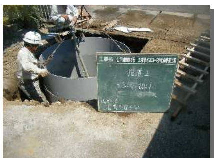
中間ケーシング 建込状況
