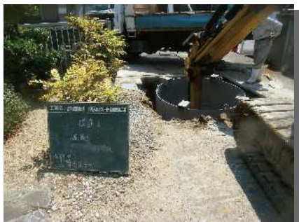
先端ケーシング内 掘削状況
