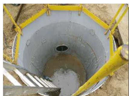
ケーシング 建込完了
