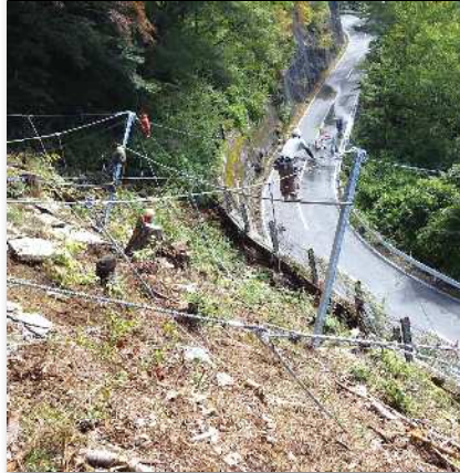
天端横主ロープを設置する。
