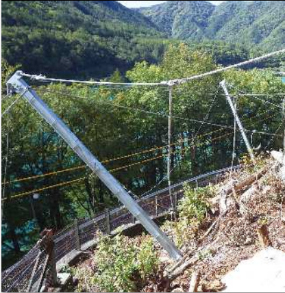
支柱および吊ロープ・サイドロープを設置する。
