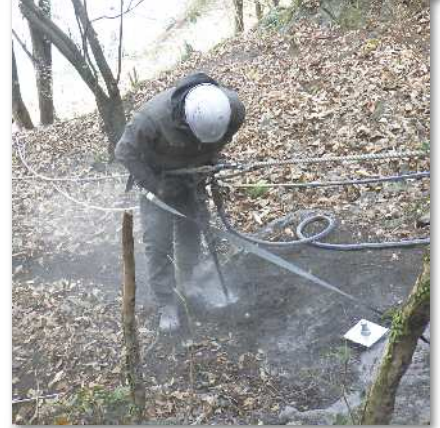
各種アンカーを設置する。(人力削孔の例)
