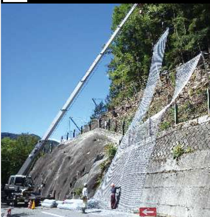
ラフテレーンクレーンにて金網を吊り上げ、設置する。
