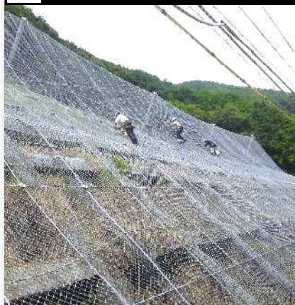
各種縦・横ロープを設置し、ロープ交点箇所を各クリップで固定した後、金網と各ロープを結合コイルで固定する。
