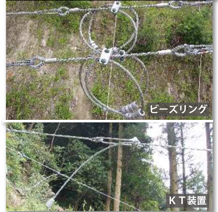
各種ロープ端部所定位置には、緩衝装置(ビーズリング・KT装置)を設置する。
